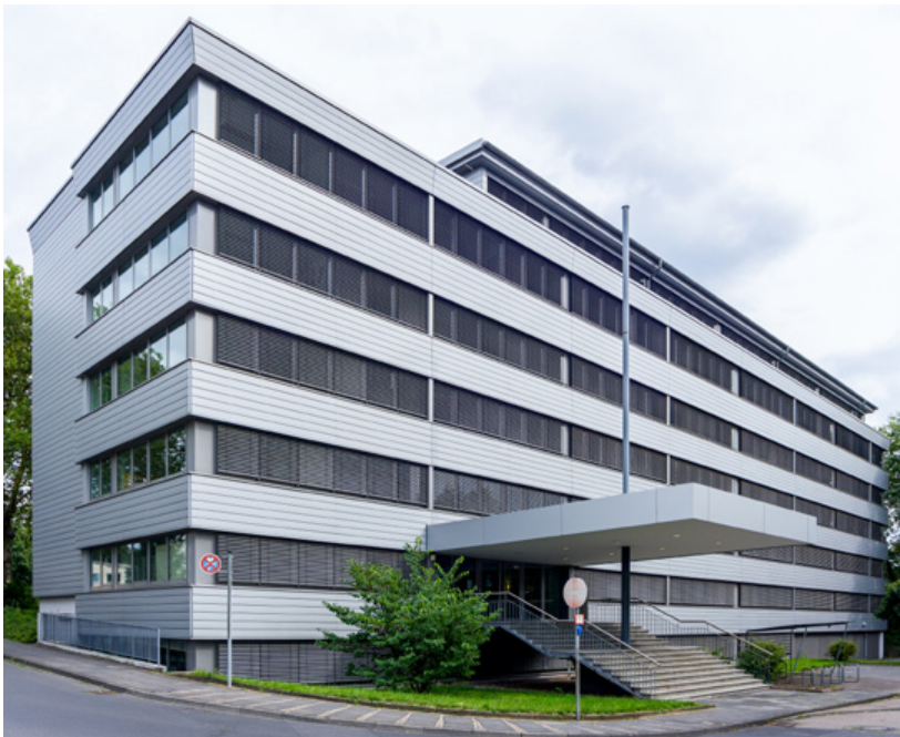
Dienststelle des Bundeszentralamtes für Steuern in Bonn-Beuel
