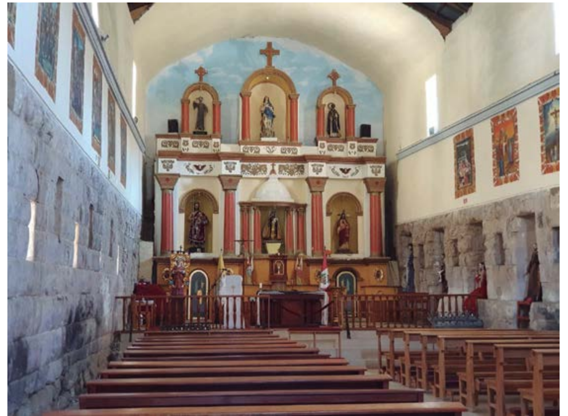
■ Vista exterior lateral e interior de la callanca inca, transformada en la iglesia San Juan Bautista en Huaytará. Huancavelica. / Lateral external view and internal view of the Callanca inca transformed into church, San Juan Bautista in Huaytará. Huancavelica.
