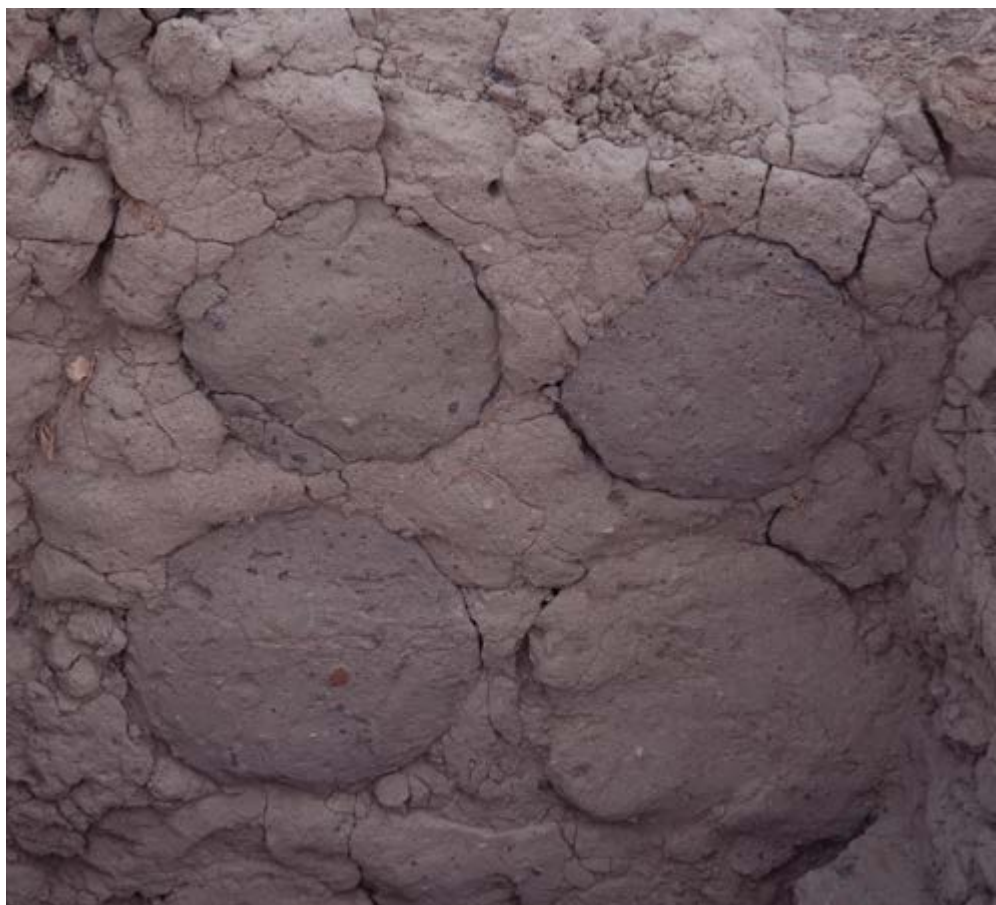
■ Detalle de muro con adobes cónicos. Cahuachi, Nazca. / Detail of wall with conical adobe bricks. Cahuachi, Nazca.
