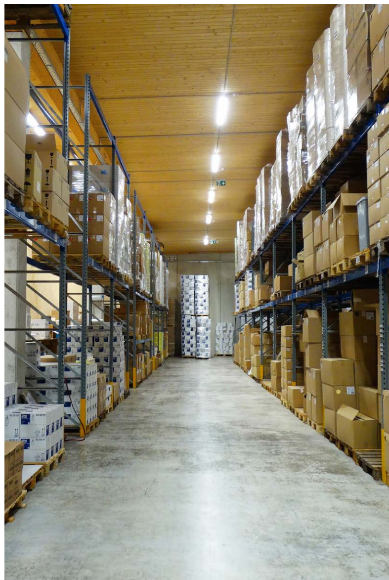
Letos so zgradili novo, sodobno opremljeno skladišče
